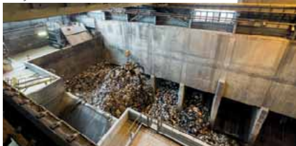
FOSSE POUR LES DÉCHETS MÉNAGERS, DU SITE ISSÉANE Issy les Moulineaux, Hauts-de-Seine
