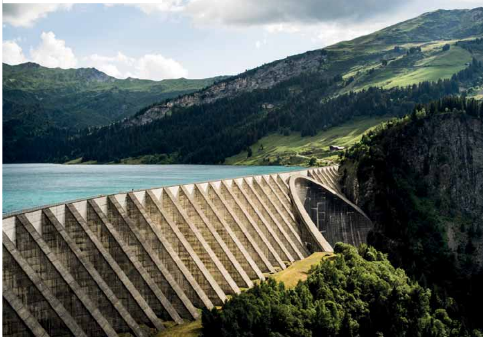
UNITÉ DE PRODUCTION ALPES GEH SAVOIE MONT BLANC Barrage de Roselend, Savoie
